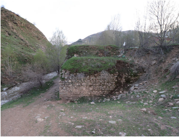
Res. 2 - Kuzeyden görünüş ve toprak, yeşil örtü ile kaplı üst örtü
