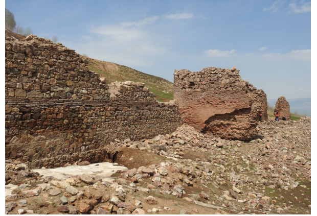
Res. 4 - Kuzey-güney doğrultulu batı duvar ve farklı örgü teknikleri
