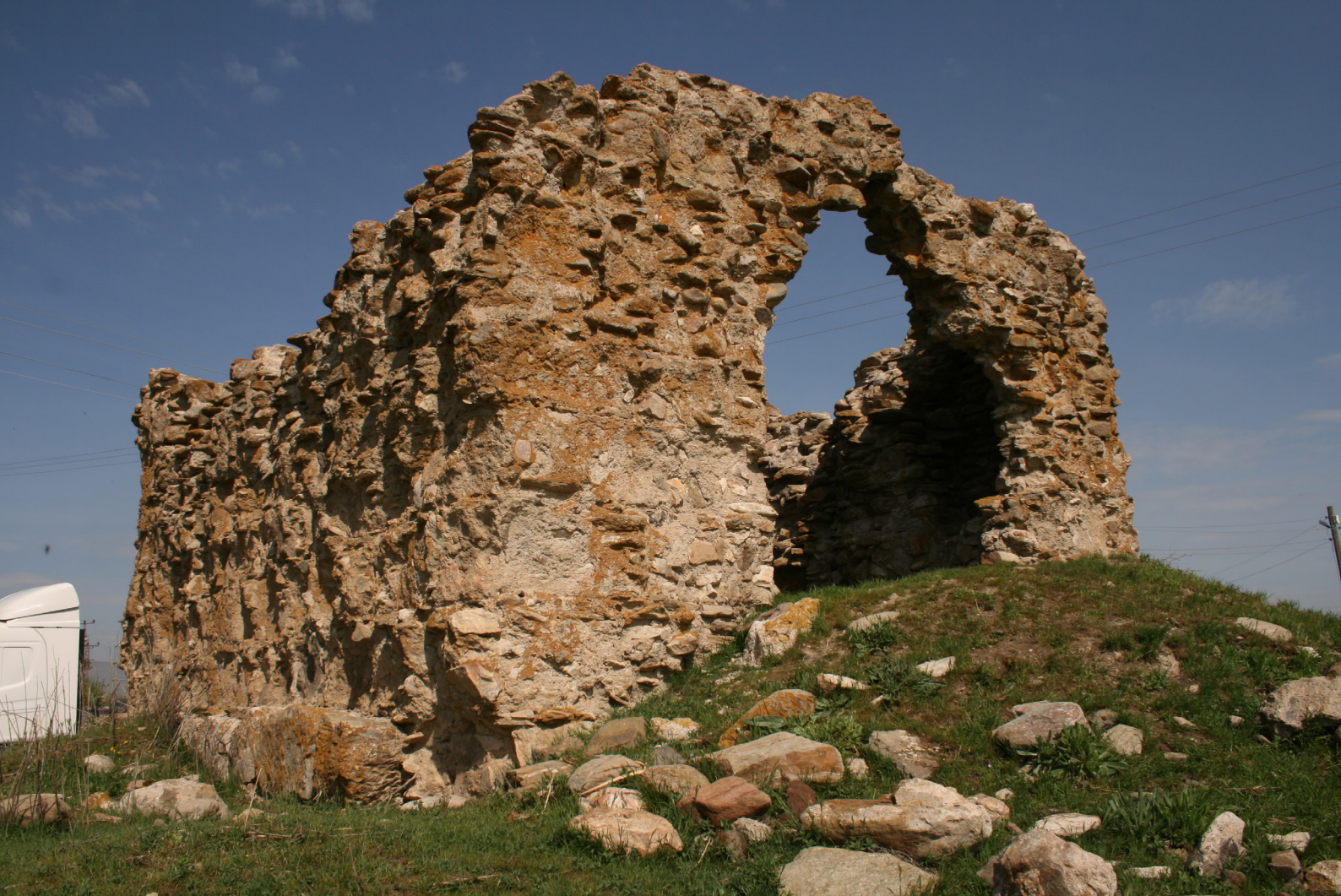
Res. 1 - Surp Tovmas Kilisesi doğudan görünüş
