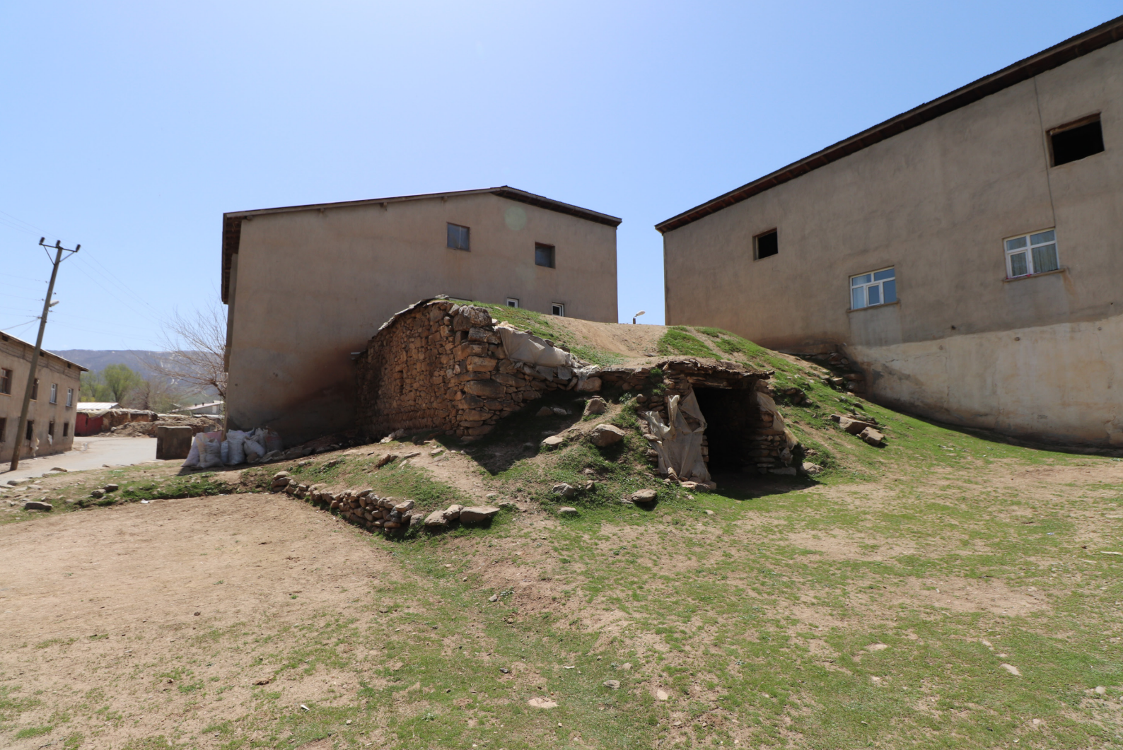
Res. 1 - Surp Giragos Kilisesi, kuzeydoğudan genel görünüş
