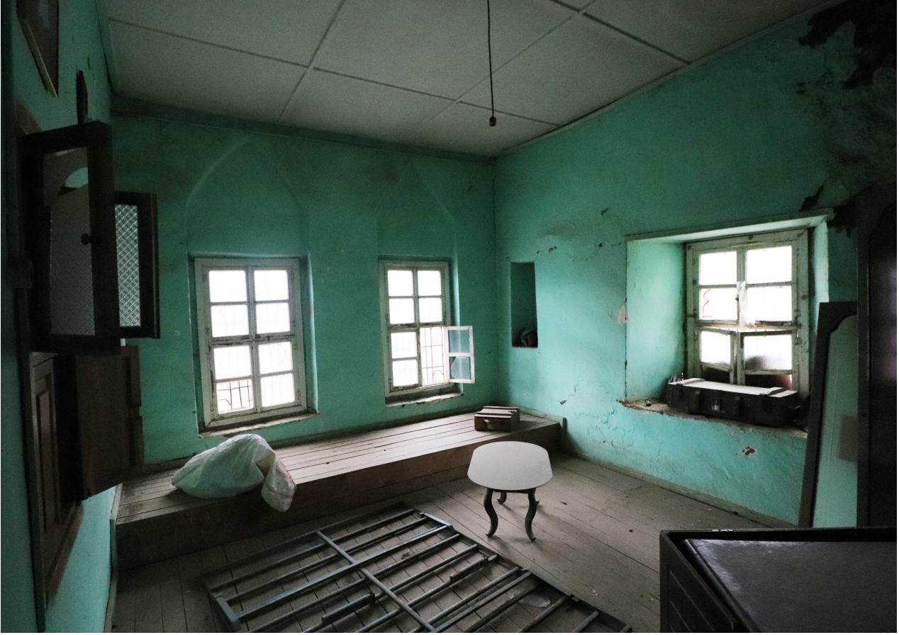
Res. 8 - Birinci kat güneydoğu odanın genel görünümü
