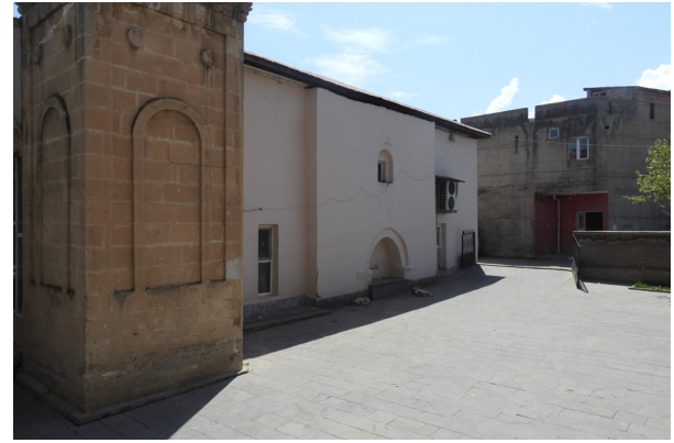
Res. 4 - Minare kaidesi ve batı cephe
