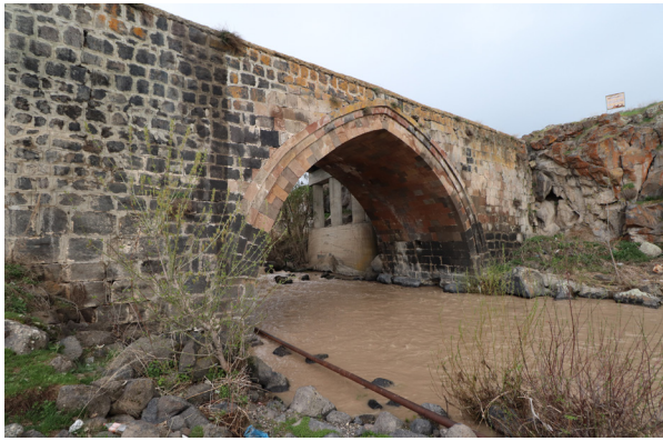
Res. 2 - Hatun Köprüsü mansap cephesi
