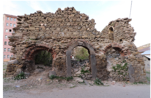
Res. 4 - Güneybatı giriş ve hatıl izleri
