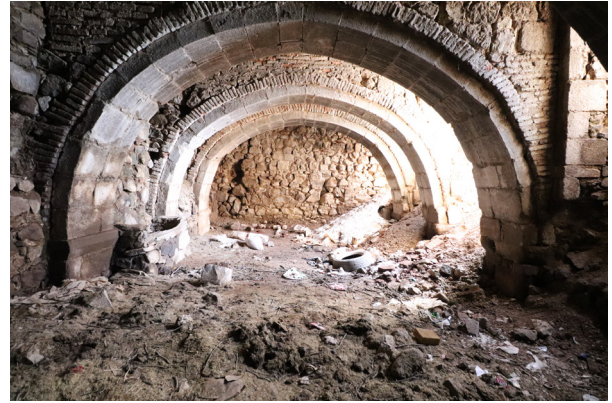
Res. 9 - Yemekhane binası (H) iç mekan, doğuya bakış
