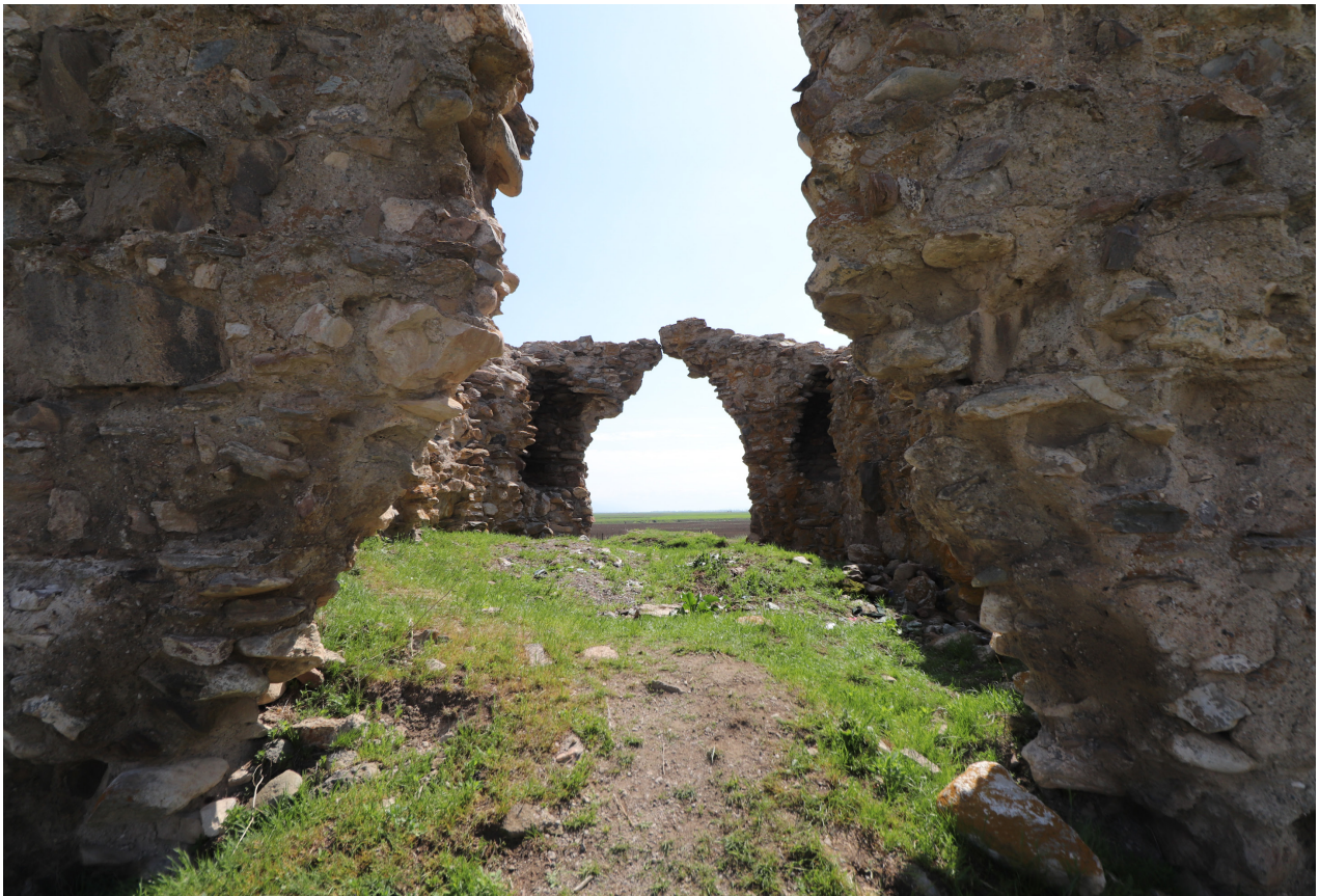
Res. 2 - Batı girişten iç mekana bakış, yıkılan batı ve doğu duvarlar
