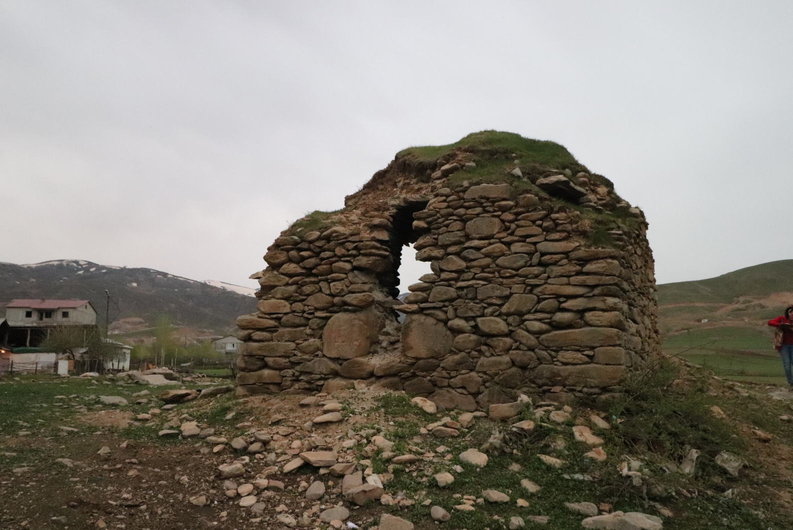
Res. 1 - Yapının ve arazinin doğudan görünüşü
