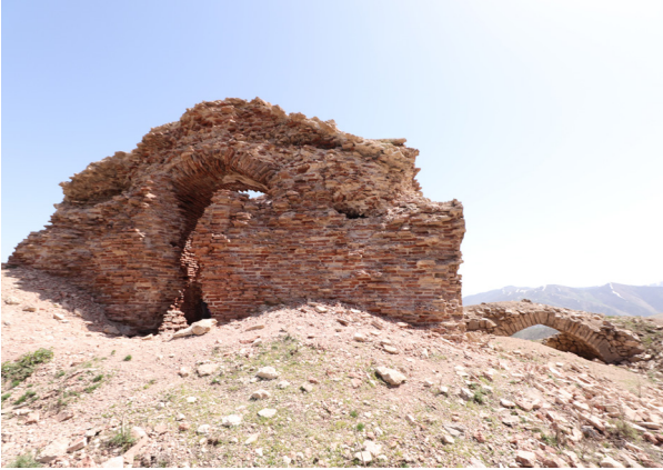
Res. 8 - Surp Arakelots Kilisesi batı cephesi ve güneyde Surp Isdepanos Şapeli tonoz kemeri
