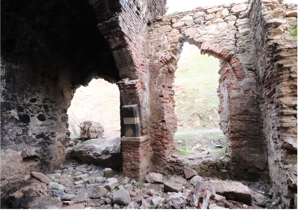
Res. 3 - Renkli taş ve tuğla örgü detayları
