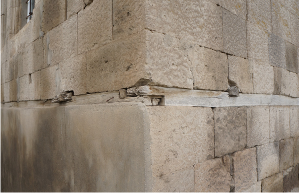
Res. 8 - Ahşap hatılların birleşme izleri
