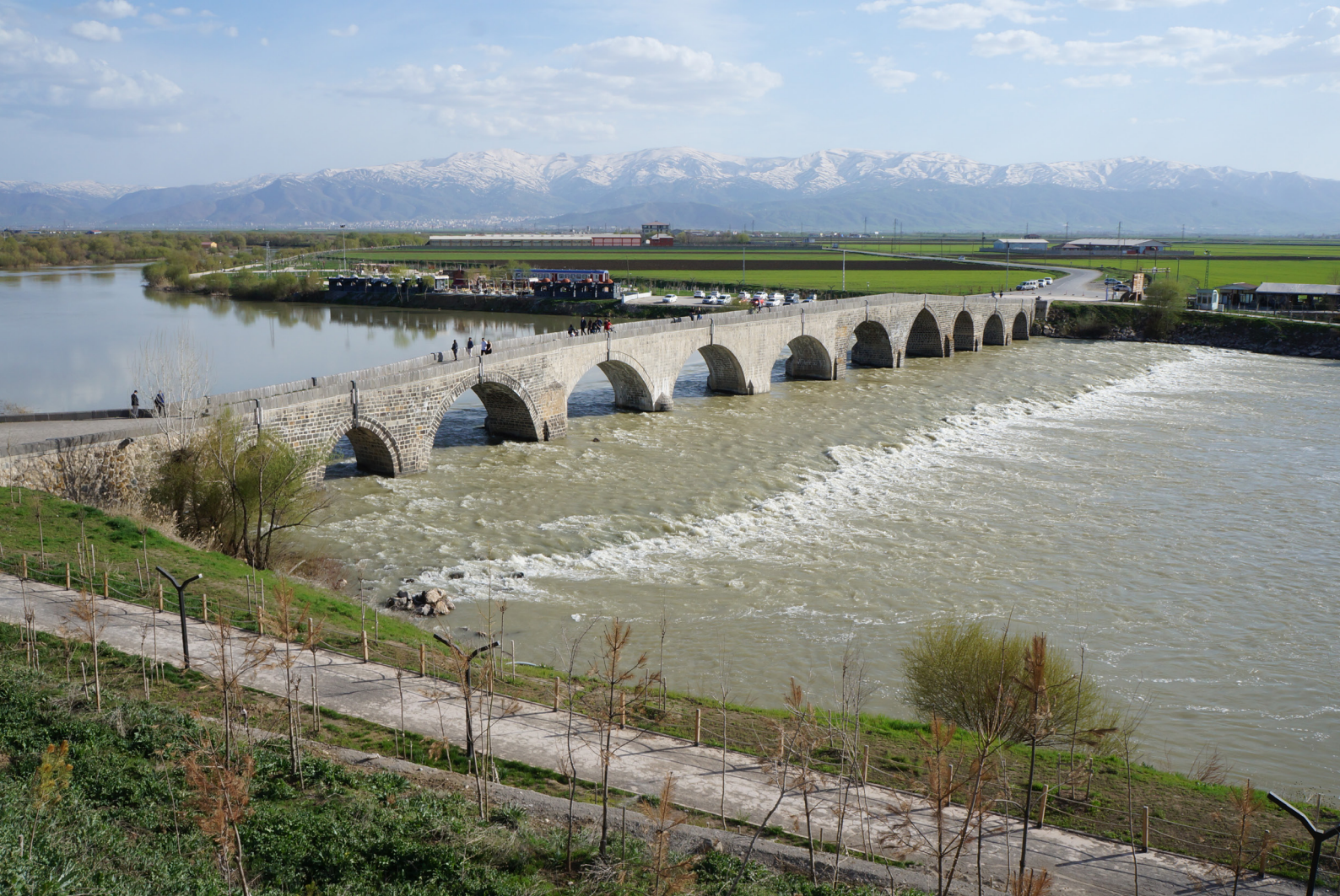
Res. 1 - Murat Köprüsü, mansap cephesi
