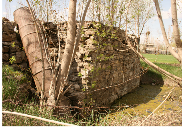
Res. 5 - Drenaj borusu, doğudan görünüş
