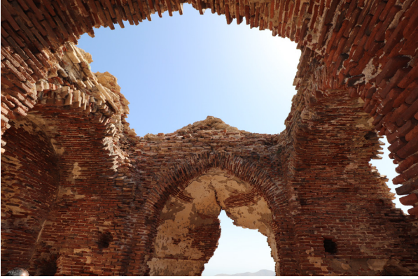
Res. 6 - Surp Arakelots Kilisesi, duvar ve kemerlerde tuğla örgü detayları
