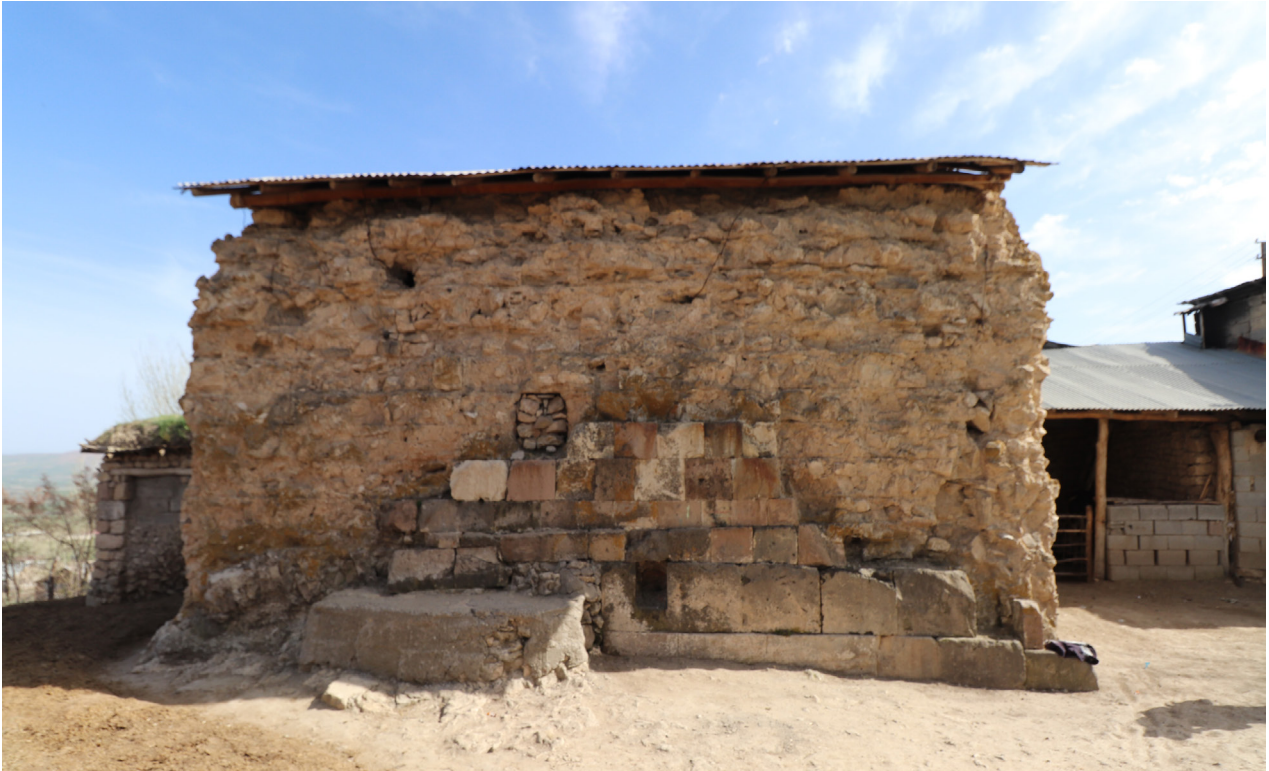
Res. 3 - Surp Sahak Kilisesi kuzey cephe
