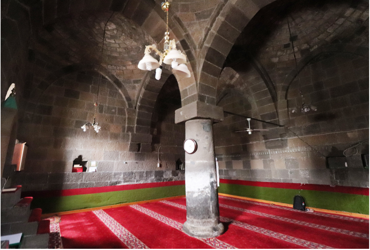
Res. 2 - İç mekan ve kubbeleri taşıyan orta sütun
