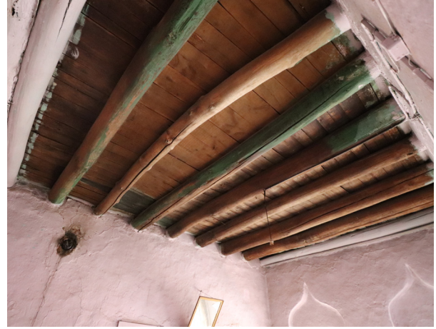
Res. 7 - Döşemeyi taşıyan daire kesitli ahşap kirişler
