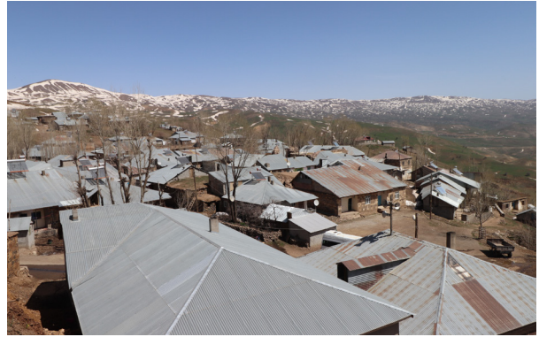
Res. 7 - Çengli Köyü güneybatıdan görünüşü
