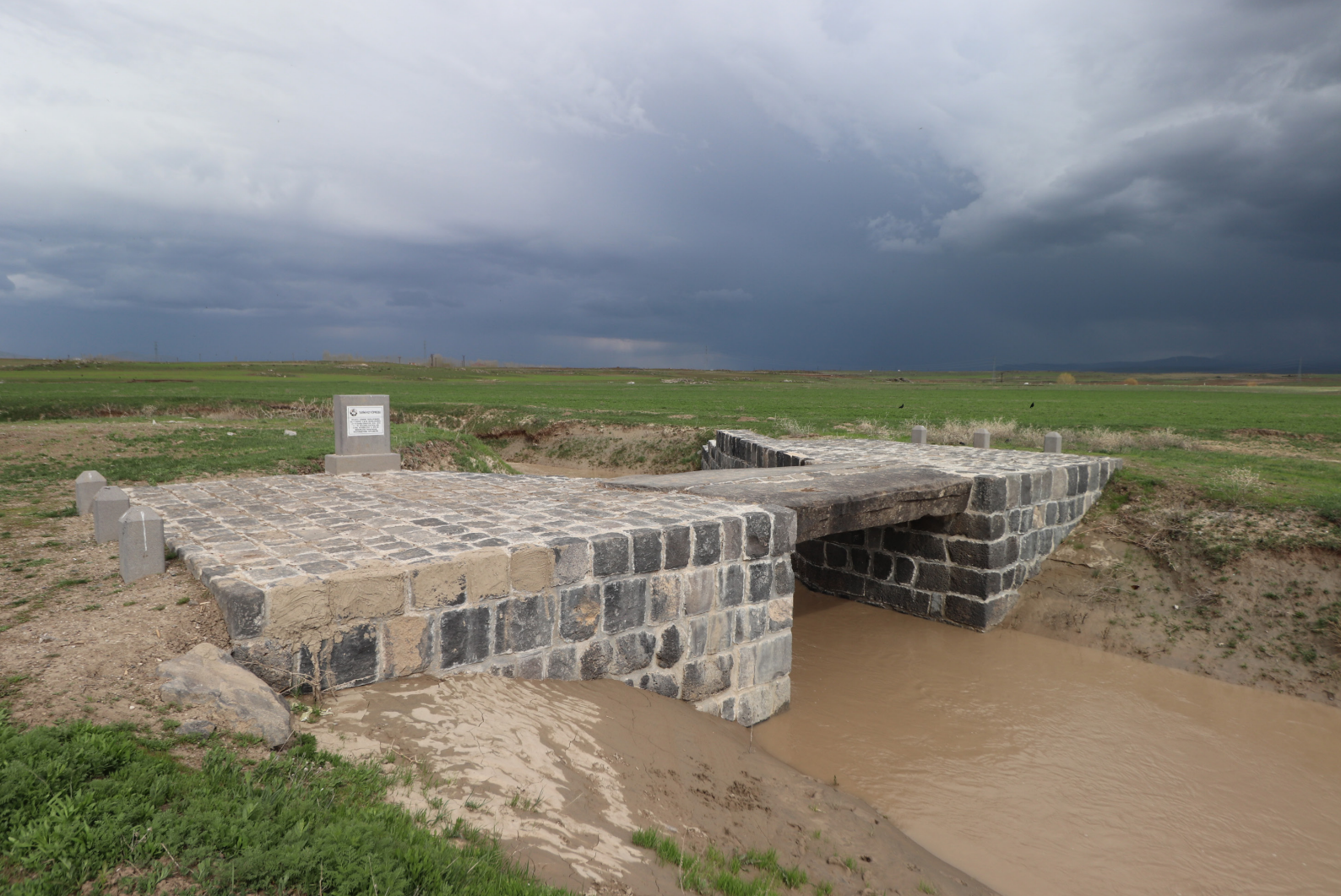
Res. 1 - Kız Köprüsü, kuzeydoğudan görünüşü
