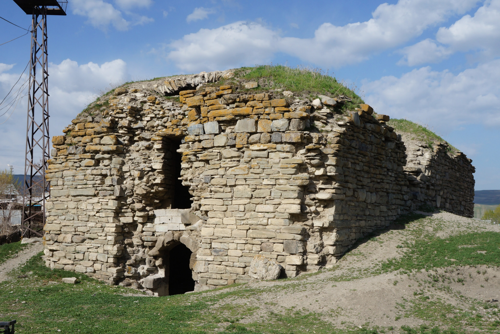
Res. 1 - Batı (giriş) cephesi, genel görünüm
