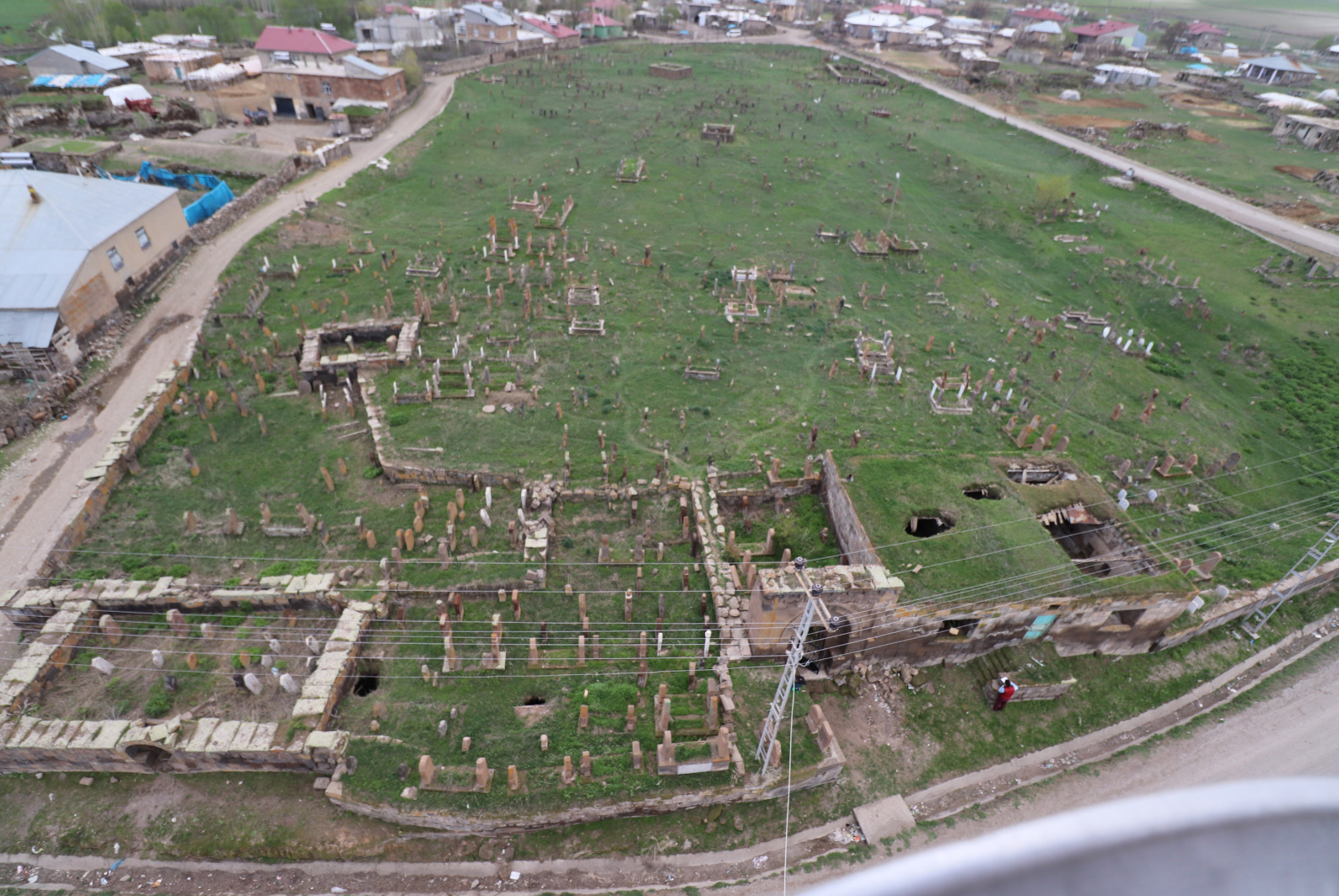
Res. 1 - Mollakent Köyü mezarlık alanı, giriş portalı ve bitişiğindeki kagir yapı
