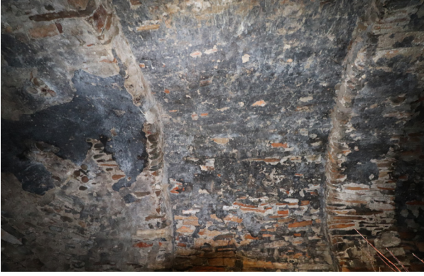
Res. 4 - İç mekan duvarları islenme detayı
