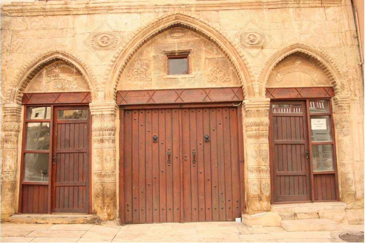
Res. 2. - Yıldızlı Han, zemin kat giriş cephesi
