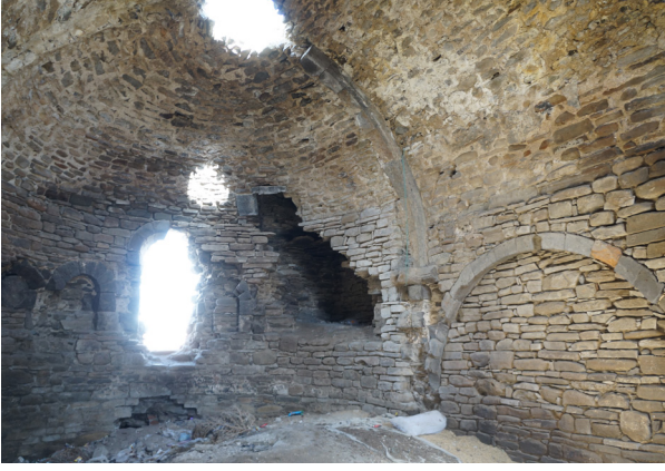
Res. 5 - Apsis ve güneyindeki merdivenli hacim
