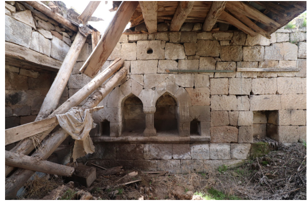
Res. 4 - Mollakent Köyü mezarlık alanındaki kâgir yapı, kesme taş duvar örgüsünde niş düzeni
