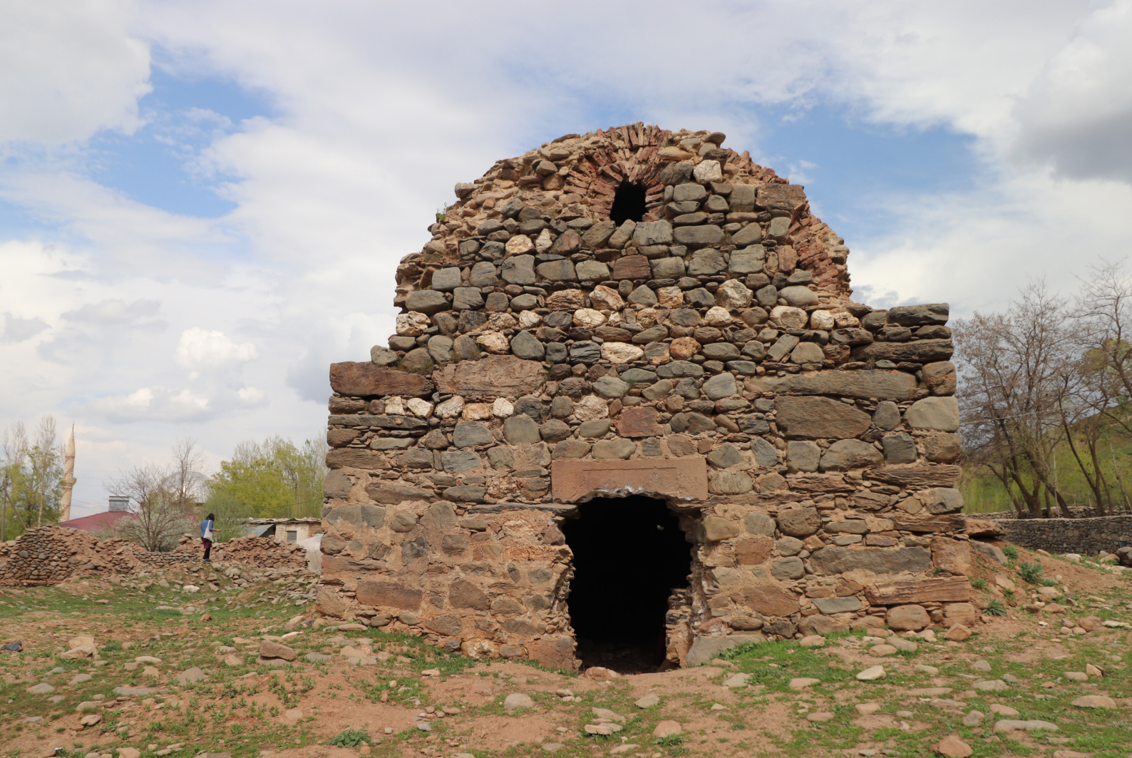
Res. 1 - Suvaran Köyü Şapeli, batı cephesi ve giriş
