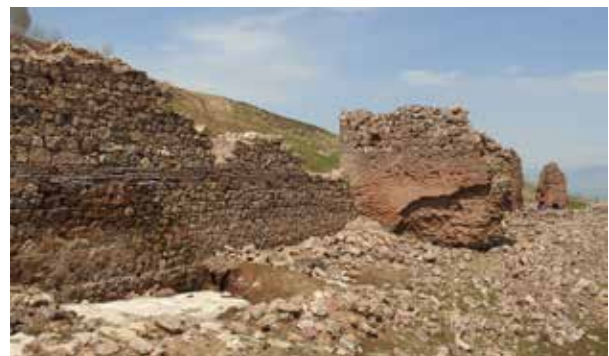
Նկ. 4 Հյուսիս-հարավ ձգվող արևմտյան թեքությունը, շարվածքի տարբեր մեթոդներ
