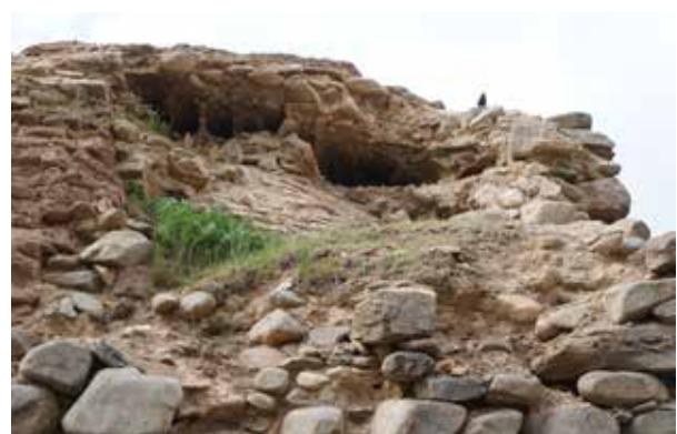
Նկ. 5 Մանրամասն, արսիդից վերև գմբեթարդի լիցքը
