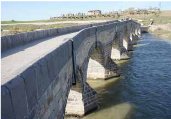
Նկ. 3 Կամրջի ջրապատնեշները հոսանքին հակառակ ուղղությամբ
