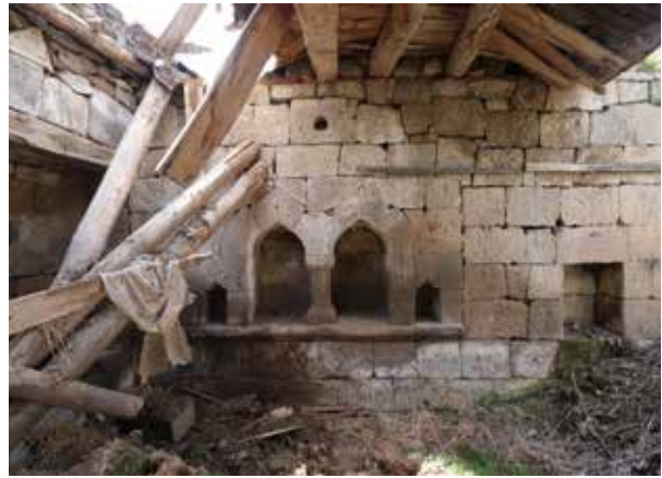
Նկ. 4 Մոլլաքյանդի գերեզմանատան քարաշեն կառույցը, պատի սրբատաշ շարվածքի մեջ խորշերի դասավորությունը
