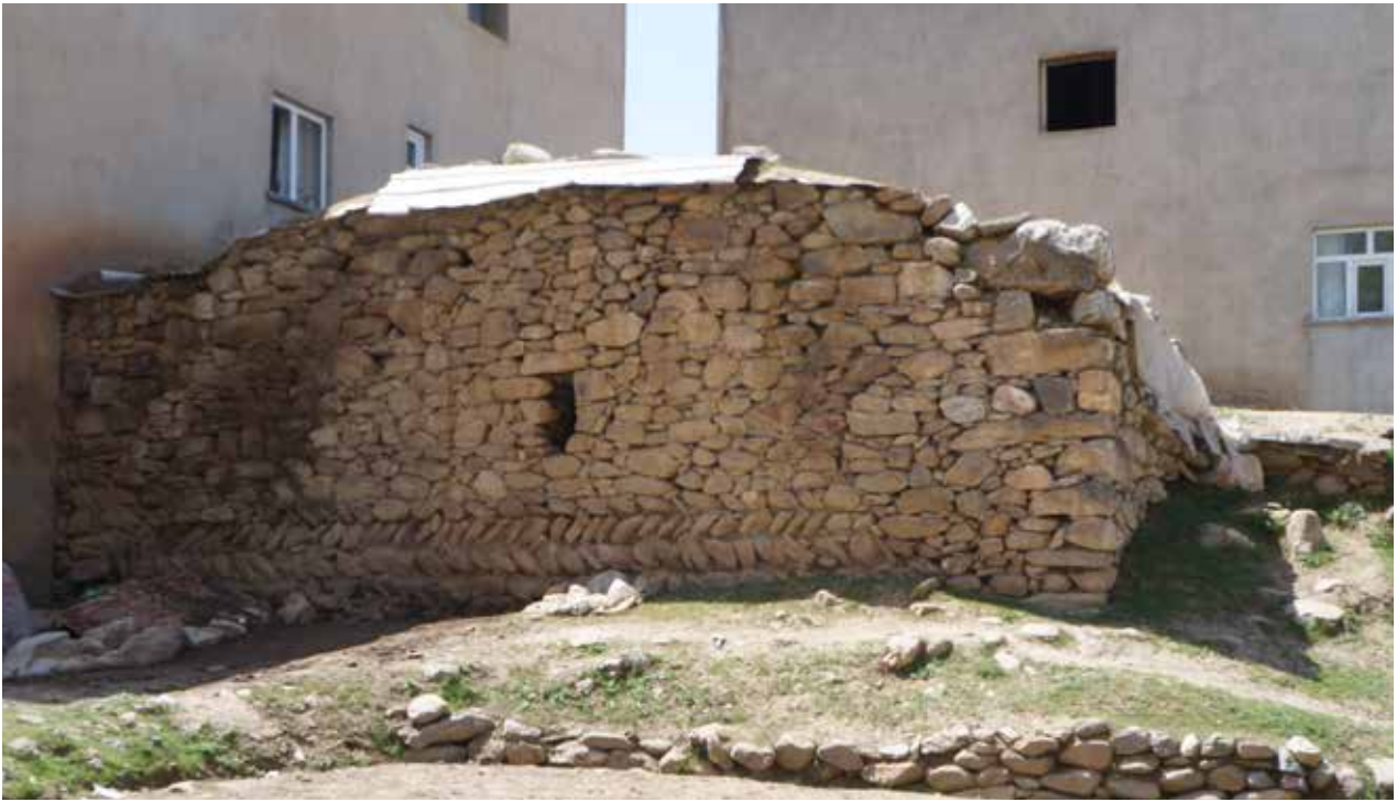
Նկ. 3 Արևելյան ֆասադը և խճաքարային շարվածքը՝ եղնաձևաձև(եղնաձև) նախշով
